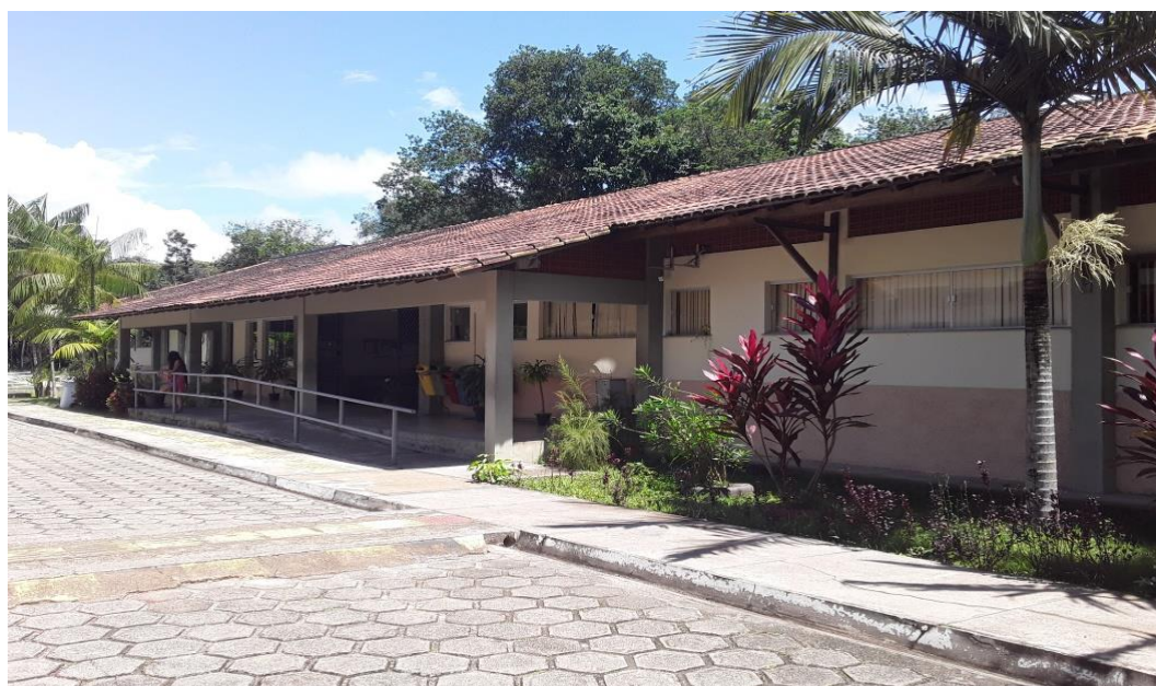
Figura 17 – Frente da Biblioteca do Campus de Abaetetuba
